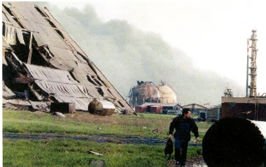
Die zerstörte, noch brennende Chemie-Fabrik in Pancevo
