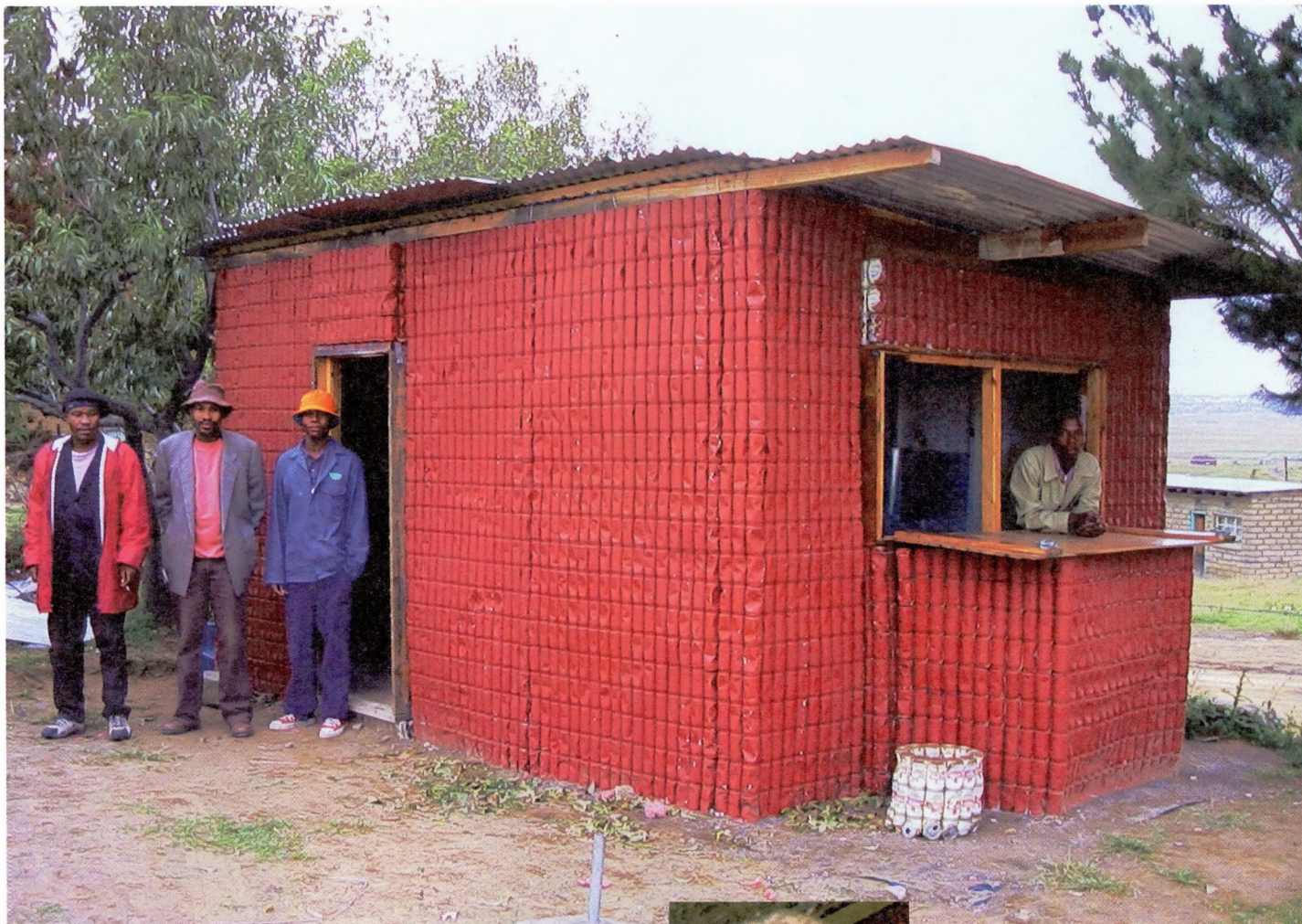
Ein fertiges Haus in Lesotho. Fenster und Türen werden durch Holz stabilisiert, gegen den Wind werden die Wände innen mit Spanplatten verkleidet
